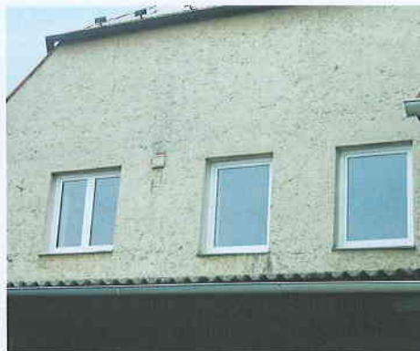
Výměna oken – vinárna
