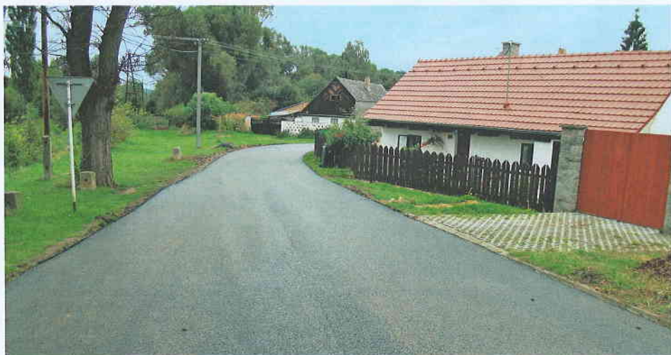
Nový povrch ul. V Chaloupkách
